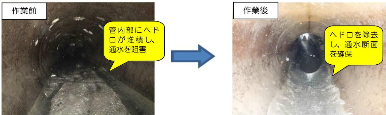
図2-4-2 維持作業（雨水管の清掃・浚渫）イメージ
